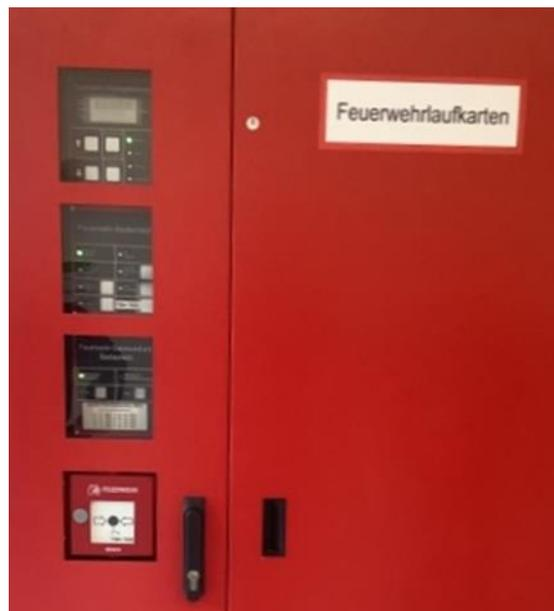
Sollte dies nicht möglich sein, ist das FGB in einem eigenen Gehäuse unterzubringen. Das FGB sollte in einer Einbauhöhe von 1500 (+100-200) mm montiert werden (gemessen von der Standfläche des Betätigenden bis Mitte Bedienfeld). Das Gehäuse ist spätestens am Tage des funktionalen Praxistestes mit der Schließung der örtlichen Feuerwehr zu verschließen.
